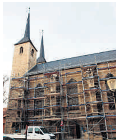
An der Außenhaut der Moritzkirche finden derzeit verschiedene Reparaturmaßnahmen statt.
