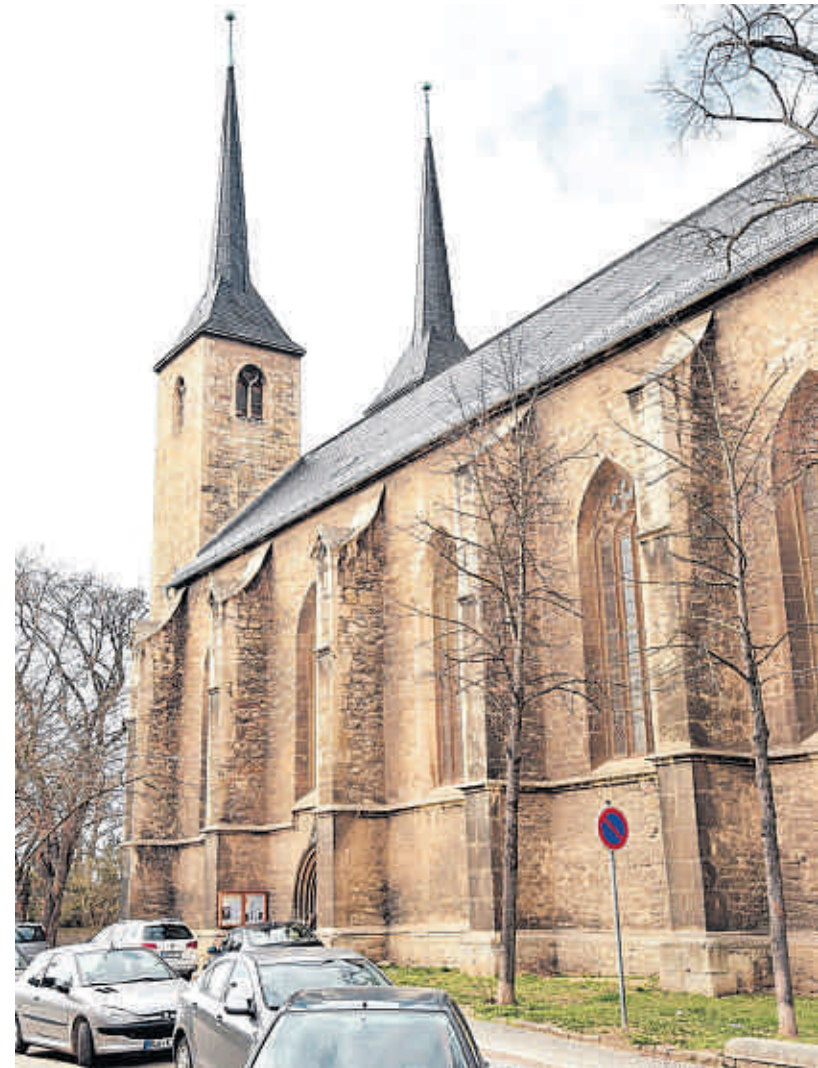
Die Naumburger Moritzkirche hat ein neues Dach erhalten. Möglich wurde das Vorhaben durch Fördermittel sowie zahlreiche Spenden. FOTOS (2): TORSTEN BIEL
